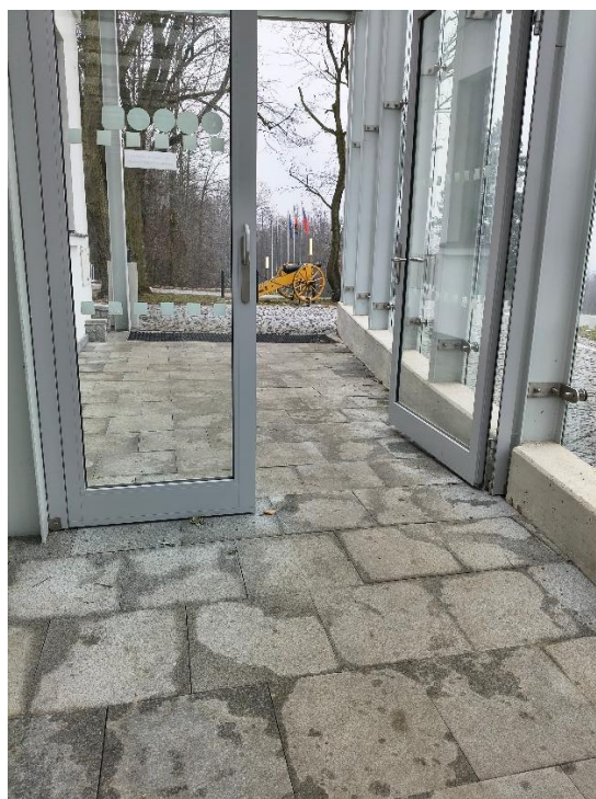
Foto 3: boční vstup do budovy
