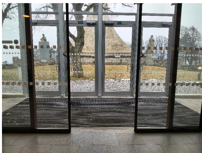
Foto 4: hlavní vstup do budovy
